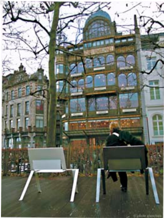
Vue face à la façade du mim
